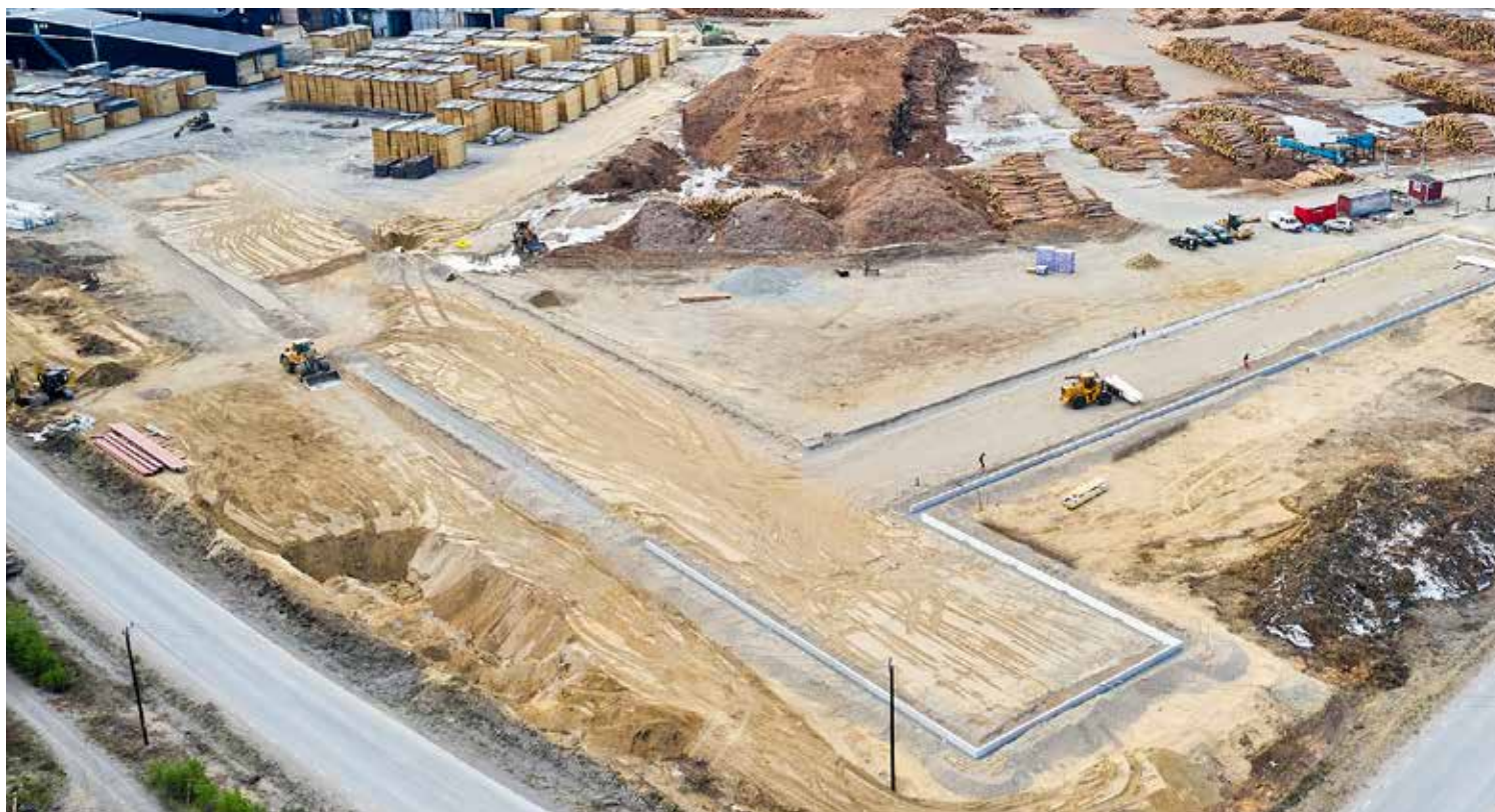
En helt ny såglinje byggs i Sikfors. I och med det får anläggningen en modern layout med plats för ny teknik.
