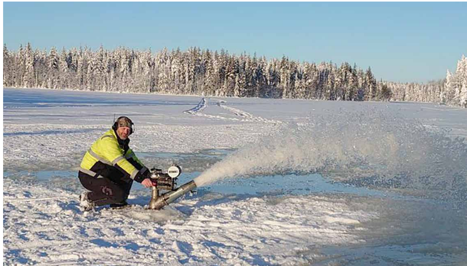
Rikard Rödlund pumpar upp vatten för att frysa till en isväg.
