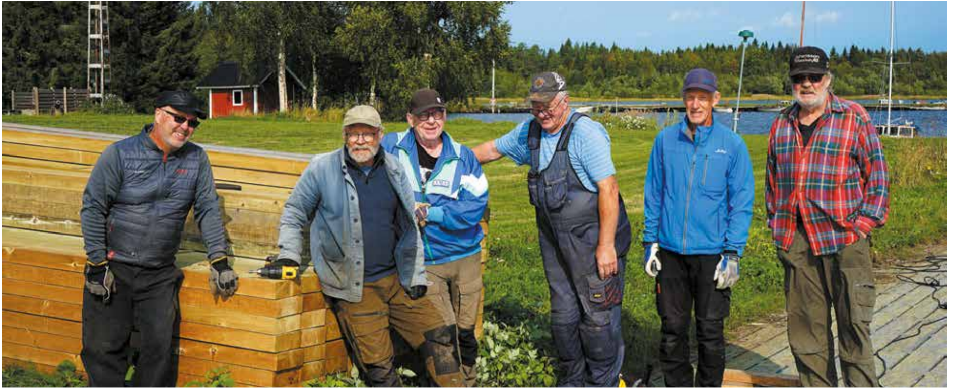
Arbetet med att restaurera hamnen i Sikeå sker helt ideellt med krafter från Stiftelsen Sikeå Hamn och Sikeå Båtklubb.
