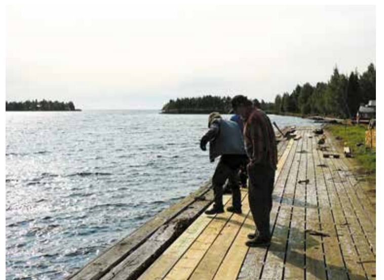
Nu återställs Sikeå hamn i brukbart skick.
