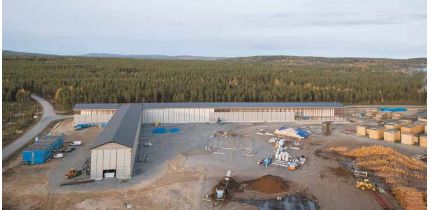
Byggnationen av det nya sågverket i Sikfors är i full gång.
