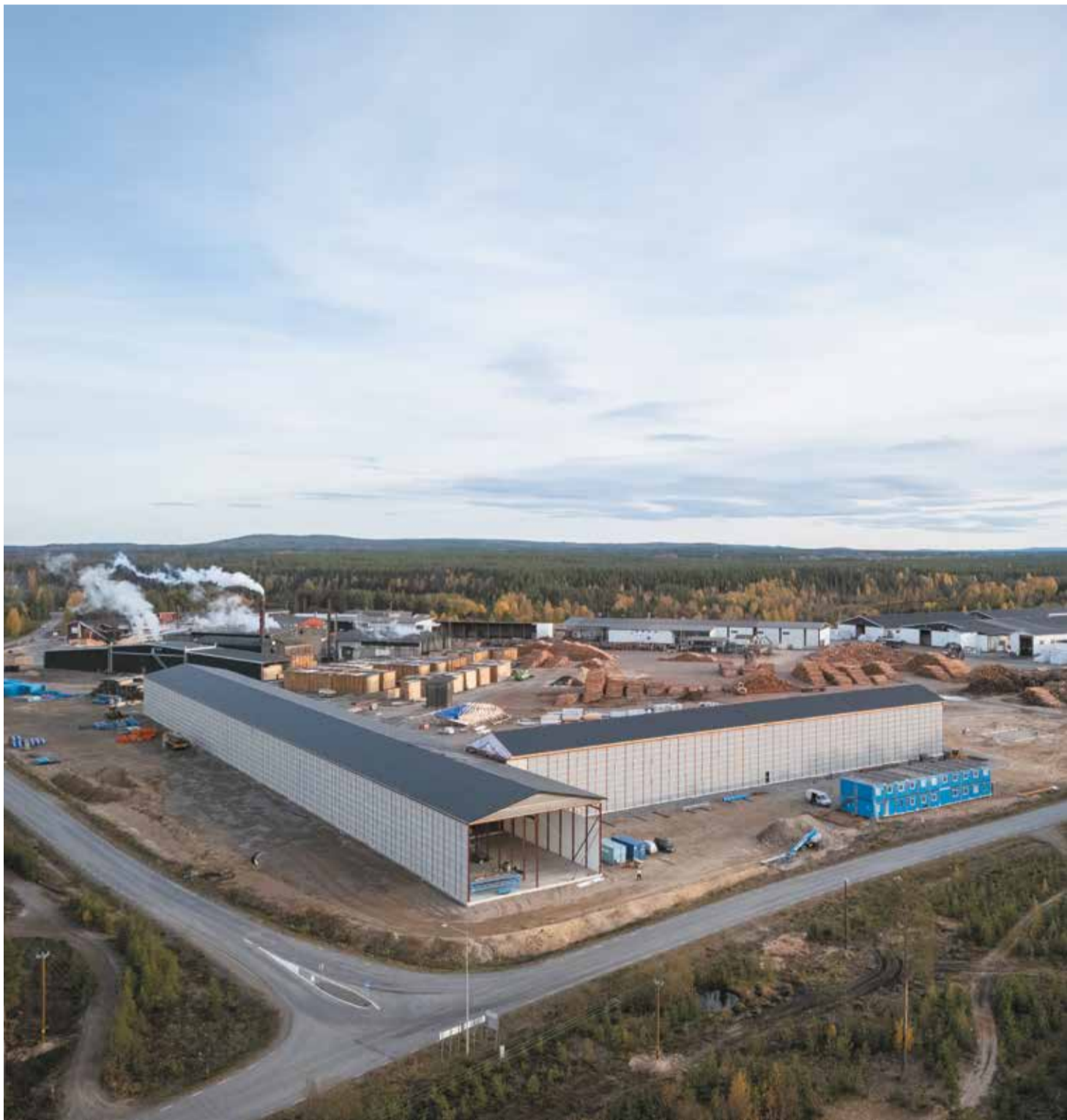
Den nya sågverksanläggningen i Sikfors börjar så saktat träda fram.
